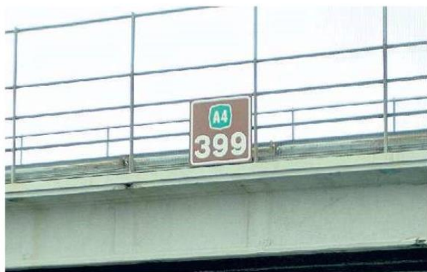
DA DEMOLIRE Il cavalcavia di Lison di Portogruaro sarà abbattuto
